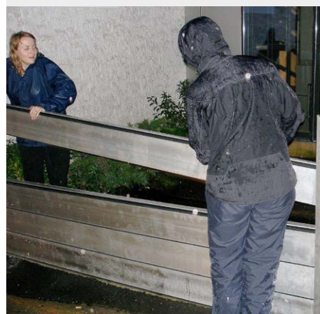
Exemple de mesure temporaire de protection contre les crues dans le quartier bernois de Matte : les panneaux en aluminium enchâssés dans un cadre métallique empêchent l'eau d'entrer dans le bâtiment.
