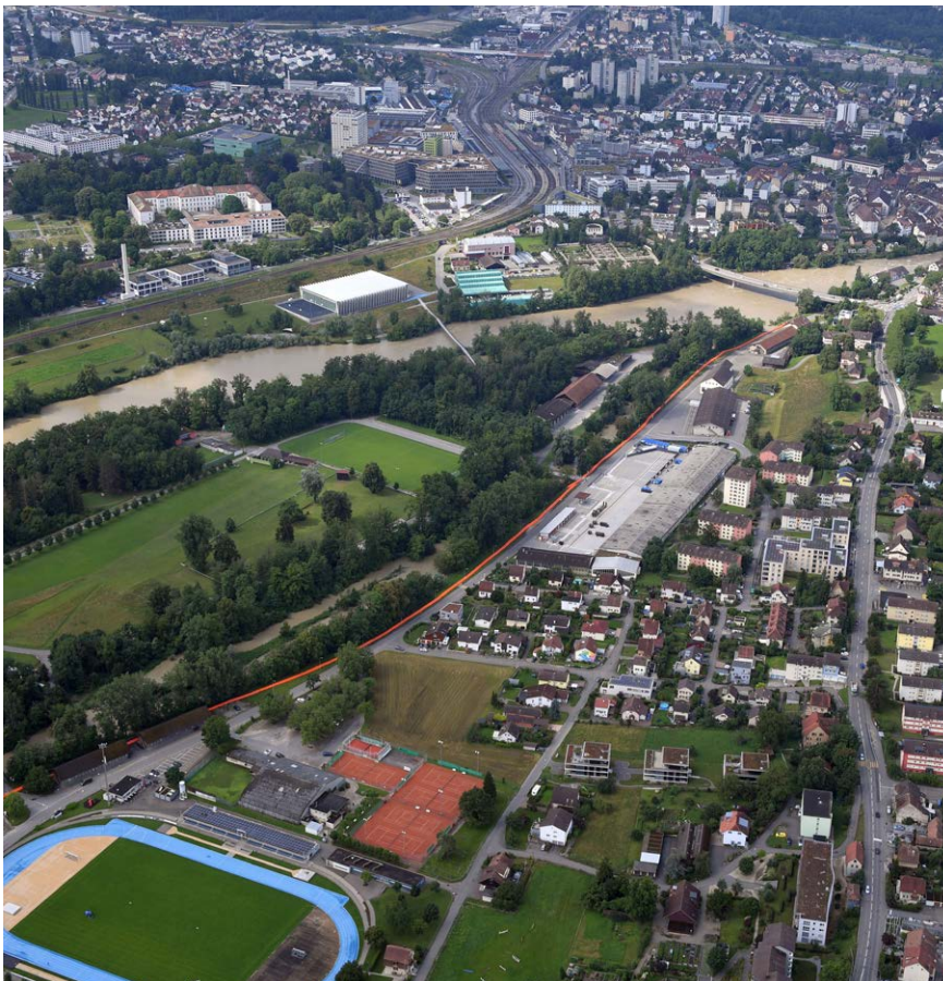
Pour protéger les zones résidentielles des débordements de l'Aar à Brügg (AG) en juillet 2021, les services de protection ont mis en place une digue de boudins Beaver® sur un long tronçon du fleuve (en orange sur la photo).
