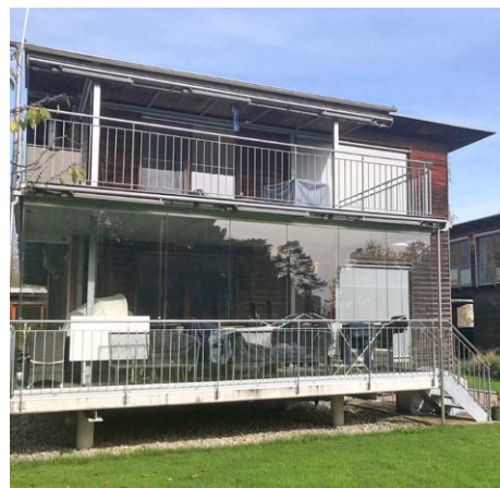
À Ipsach (BE), sur la rive sud du lac de Biemme, ces maisons individuelles ont été construites sur pilotis dans une zone exposée aux inondations, ce qui limite le risque de dégâts en cas de hautes eaux.
