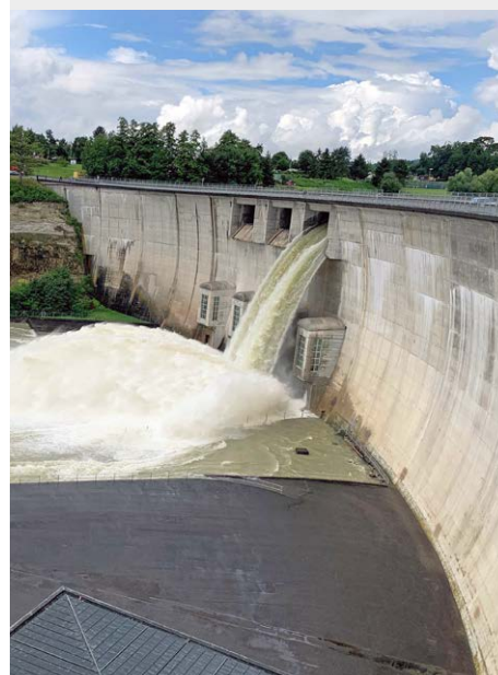
Évacuateur de crues du barrage du lac de Schiffenen. En cas de forte hausse du débit de la Sarine, ces volumes d'eau ne peuvent pas être retenus dans le lac, de capacité insuffisante.
