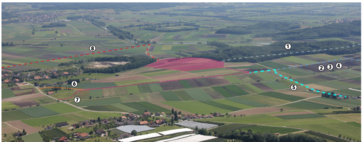
Abb. 2: Schrägaufnahme von Nord nach Süd auf das Beichfeld (rosa) und Teile der verschiedenen Erschliessungsvarianten. Links im Bild das Dorf Walperswil, unten im Bild die Häuser von Epsach.
