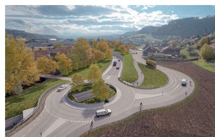
Kreisel Oberburg Nord mit Tunnel-einfahrt
