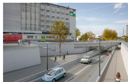
zwei neue Bahnunterführungen in Burgdorf
