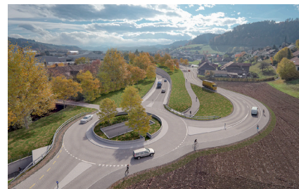
Kreisel Oberburg Nord mit Tunnel-einfahrt
