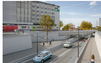
zwei neue Bahnunterführungen in Burgdorf
